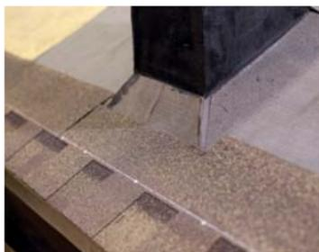
При устройстве примыкания к трубе необходимо устроить галтель\* в месте стыка ската кровли с вертикальной поверхностью. Завести подкладочный ковер на галтель, затем подрезать по месту.
