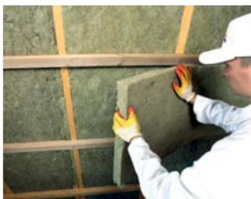
Необходимо установить дополнительную деревянную или металлическую обрешетку нужной толщины со стороны помещения. Направляющие для каркаса устанавливаются поперек стропил для того, чтобы перекрыть возможные мостики холода. В получившийся дополнительный каркас уста-
