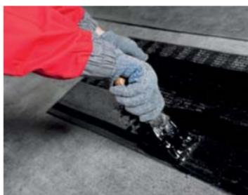
В случае устройства выкройки из рядовой черепицы или использования рядовой черепицы в качестве стартовой полосы необходимо промазать тыльную сторону в зоне отсутствия клейкого слоя мастикой ТЕХНОНИКОЛЬ ФИКСЕР, толщиной не более 1 мм.
