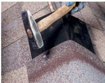
Фиксация производится на 2 гвоздя длиной не менее 60 мм, ориентируясь на линию прибивания гвоздей, отформованную на коньковом аэраторе
