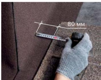
Произвести укладку гибкой черепицы. На левой и правой частях гибкая черепица заводится на выкройки из ендового ковра таким образом, чтобы желоб между черепицей и галтелью был шириной 80 мм.
