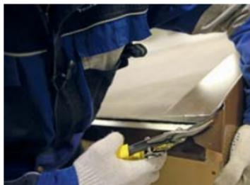
Фронтонную планку уложить поверх подкладочного ковра с нахлестом 30–50 мм, предварительно подрезав планку по месту.
