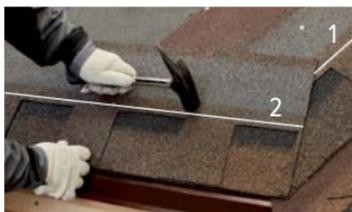
Монтаж рядовой черепицы по горизонтали произведите от линии установки вертикального гонта. Механическая фиксация должна осуществляться на расстоянии 300 мм от оси ендовы. Таким же образом установить рядовую черепицу на соседнем скате.
