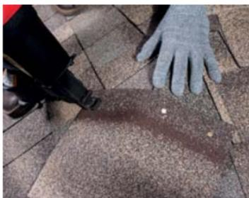
Укладываем черепицу снизу вверх после отбивки габаритов будущего ребра (две полосы вдоль ребра) с помощью шнура (отбивки).
