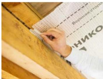
Маркированная сторона пленки должна быть обращена к монтажнику. Монтаж пленок производится внахлест (примерно 10 см), на каждый рулон нанесены маркировочные линии. Пленку следует монтировать с натягом, не допуская провиса и складок, чтобы надежно проклеить нахлест рулонов и исключить деформацию утеплителя.
