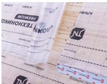
Нахлест полотен составляет 100–200 мм. Швы и места крепления пленки степлером герметизируются с помощью двусторонней соединительной ленты.
