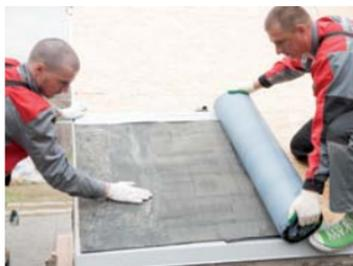
Выровнять и приклеить часть полотна к основанию, оставшуюся часть завернуть до места приклейки материала.
