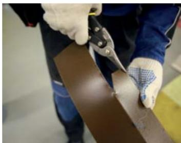
Перед выполнением ендовы или ребра карнизную планку необходимо подрезать по месту, оставляя часть планки для завода на противоположный скат.
