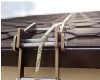
**ВАЖНО!** Для защиты кровельного покрытия от воздействия веревки и защиты самой веревки от перетирания на места перегиба кровли рекомендуется устанавливать фабричные или самодельные протекторы.
