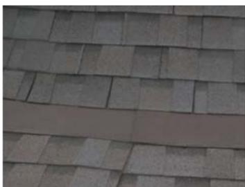
Монтируем последующие ряды гибкой черепицы, сдвигая швы гибкой черепицы на половину ширины выкройки. Подрезаем гибкую черепицу по вертикальным линиям разметки. Смонтировать гибкую черепицу на нижележащем скате, заводя ее под ендовный ковер в месте перехода на купольную часть.
