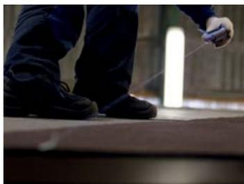
Произвести отбивку мелованных линий подреза и фиксации с помощью шнурки (отбивки).
