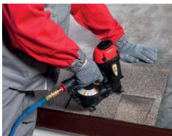
Коньково-карнизная черепица и выкройка из рядовой черепицы фиксируются кровельными гвоздями в количестве не менее 12 гвоздей на гонт. Рядовую черепицу фиксировать согласно схеме.
