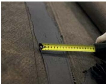
Эндовый ковер промазать по периметру тыльной стороны битумной мастикой ТЕХНОНИКОЛЬ ФИКСЕР на ширину 100 мм.
