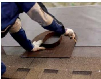
Отметить будущее положение проходки на сплошном основании и вырезать отверстие.
