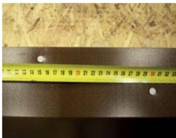
Карнизные планки укладывать ребром на край сплошного основания до монтажа подкладочного ковра. Крепить кровельными гвоздями в шахматном порядке с шагом 120–150 мм.
