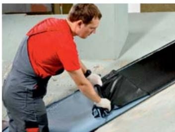
С одной части подкладочного ковра удаляется защитная пленка.
