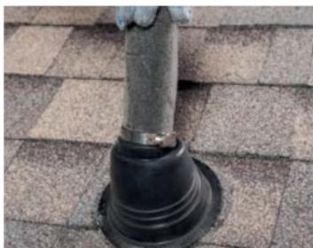
Смонтированная проходка с помощью резинового уплотнителя.
