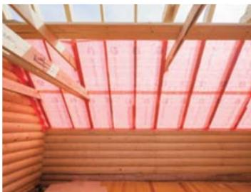
Нахлест полотен составляет 100–200 мм. Швы и места крепления пленки степлером герметизируются с помощью герметизирующих лент ТЕХНОНИКОЛЬ АЛЬФАБЭНД.
