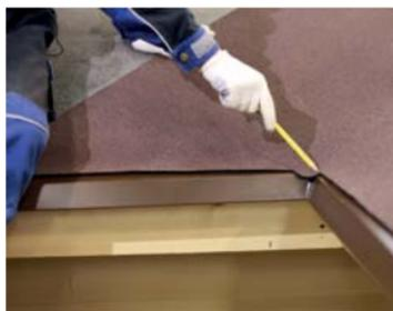
**ВАЖНО!** Необходимо укладывать ендовный ковер со смещением по горизонтали на 20–30 мм относительно подкладочного ковра.
