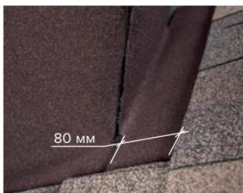
Произвести укладку гибкой черепицы с тыльной стороны. Гибкая черепица заводится на выкройку из ендовного ковра таким образом, чтобы желоб между черепицей и галтелью был шириной 80 мм.
