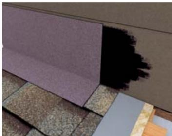
Поверх рядовой черепицы смонтировать полосы ендового ковра ТЕХНОНИКОЛЬ: на праймированную поверхность полоса заводится не менее чем на 300 мм\*, на рядовую черепицу – 200 мм.
