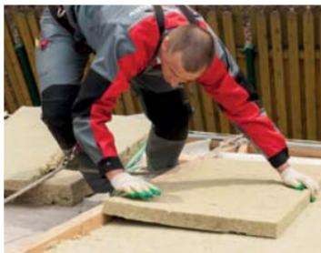
Теплоизоляционные плиты монтировать в распор между стропилами. При утеплении в несколько слоев плиты укладывать с перекрытием швов.
