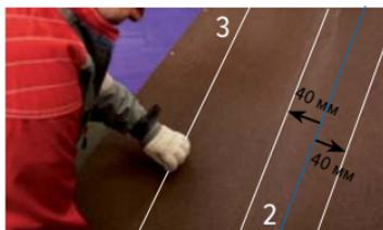
Проведите отбивку мелованных линий установки вертикального гонта и линий фиксации вертикального гонта с помощью шнура-отбивки.
