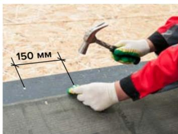
Выполнить механическую фиксацию материала ершенными кровельными гвоздями в зоне продольного перехлеста. Шаг крепления гвоздей составляет 150 мм и выполняется в разбежку.
