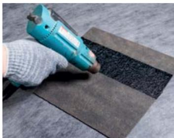
Если кровельные работы проводятся при температуре ниже  $+5^{\circ}\text{C}$ , упаковки с гибкой черепицей ТЕХНОНИКОЛЬ SHINGLAS следует подавать по 5–6 пачек, выдержанных не менее 24 часов в помещении с температурой воздуха не менее  $+20^{\circ}\text{C}$  или в организованном на строительной площадке тепляке,
