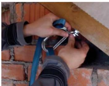
Анкерная точка с использованием шпильки  $\text{Ø}10\text{--}12$  мм.
