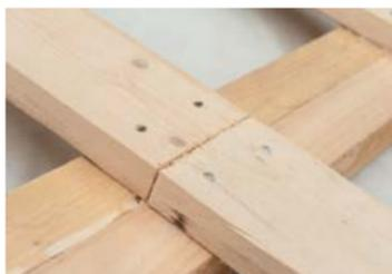
Поперечное соединение двух элементов разрезанной обрешетки в одном ряду производить таким образом, чтобы стык досок приходился на стропильную ногу, механическая фиксация по 2 шт. на каждый край доски.
