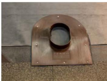
Механически зафиксировать проходной элемент с помощью 8 кровельных гвоздей по периметру.
