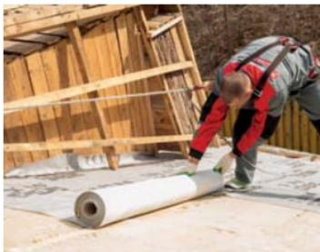
При укладке мембраны произвести перехлест полотен не менее 100 мм по горизонтали и по вертикали. Перехлесты полотен проклеиваются с помощью монтажной акриловой или бутил-каучуковой ленты.
