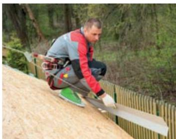
Карнизный свес кровли усиливается металлическими карнизными планками.
