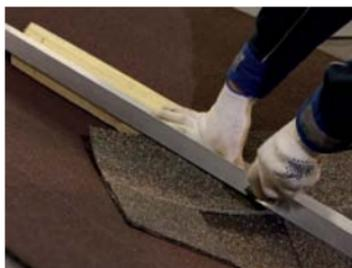
Подрезать рядовую черепицу по линии подреза, используя специальную деревянную дощечку, чтобы не повредить целостность гидроизоляционного слоя.
