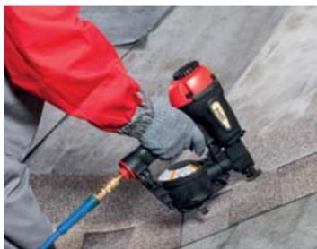
Зафиксировать каждый гонт гибкой черепицы с помощью кровельных гвоздей по линии фиксации (на расстоянии не менее 300 мм от оси ендовы).
