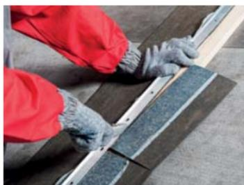
В случае устройства выкройки из рядовой черепицы произвести подрезку лепестков гонта по заранее размеченной линии.
