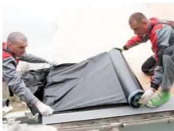
Затем приклеить оставшуюся часть полотна, одновременно раскатывая и снимая защитную пленку с рулона.
