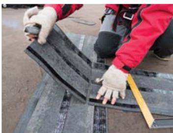
Разрезать гонт гибкой черепицы на 3 части — на выкройке по 330 мм.
