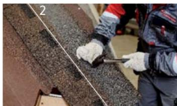
Смонтируйте подготовленные гонты параллельно оси ендовы по линии на кровельные гвозди по 5–8 гвоздей на рядовую черепицу в зависимости от угла наклона кровли. До 45° — 4 гвоздя, свыше — 8 гвоздей.
