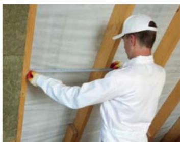
Рекомендуемое расстояние между стропилами внутри 580–590 мм. Деревянные конструкции должны быть обработаны защитными составами.
