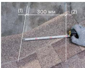
Не следует прибивать специальные гвозди ближе линии фиксации **(2)** (на расстоянии 300 мм от центральной оси ендовы **(1)**).
