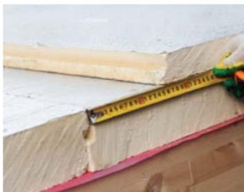
Произвести укладку плит LOGICPIR PROF Ф/Ф поверх пароизоляционного слоя. При утеплении в несколько слоев плиты укладываются с перекрытием швов.
