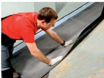
Эта часть подкладочного ковра приклеивается к основанию. В момент приклеивания следует аккуратно разглаживать полотно, избегая образования складок.
