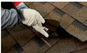
С тыльной стороны гонта, который подходит к ендове, в местах отсутствия клеящего слоя, на расстоянии 100 мм нанесите битумную мастику ТЕХНОНИКОЛЬ ФИКСЕР, толщиной строго не более 1 мм.
