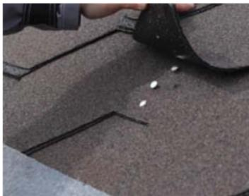
При завершении кровельных работ кронштейны снимаются, а места крепления закрываются лепестком вышележащей черепицы.
