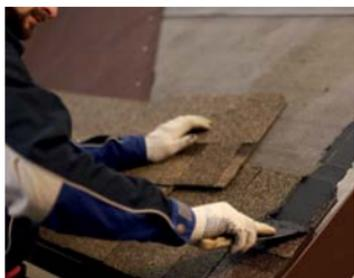
Битумная мастика наносится как на торцевую планку, так и на невидимую часть гонта черепицы, который подходит к торцевой планке. Нанести битумную мастику ТЕХНОНИКОЛЬ ФИКСЕР слоем толщиной не более 1 мм, полосой шириной 100 мм.
