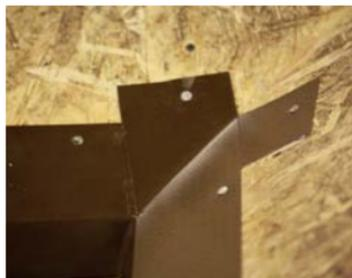
■ Закрепить карнизную планку в ендове с помощью кровельных гвоздей.
