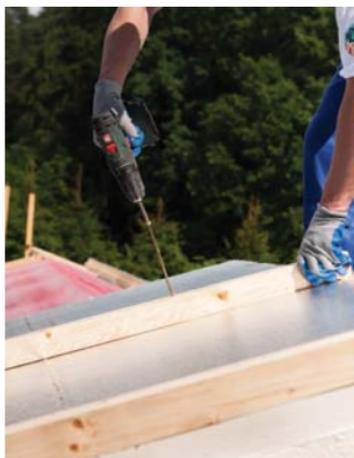
Плиты фиксировать с помощью специального крепежа Termoclip WST 5,5 через брус для создания вентиляционного зазора. Шаг бруса должен соответствовать шагу стропил.
