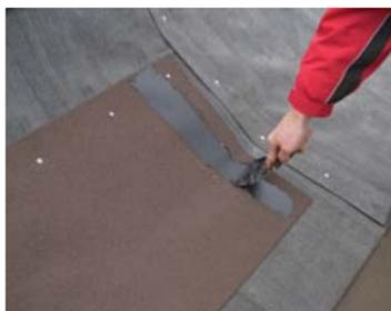
Механически зафиксировать ендовый ковер, промазать нахлесты мастикой ТЕХНОНИКОЛЬ ФИКСЕР. Нахлест должен быть не менее 100 мм.
