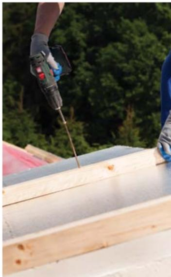
Вентилируемый канал выполняется с помощью деревянного бруса контробрешетки или брусков XPS CARBON ECO. Шаг бруса должен соответствовать шагу стропил. Брус механически фиксируется:
