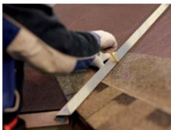
Произвести укладку рядовой черепицы до линии подреза в сторону оси ендовы и осуществить разметку линии подреза.
