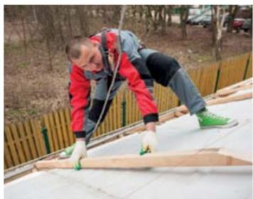
Вентиляционный канал над теплоизоляцией и диффузионной мембраной должен иметь высоту продуха 50 мм при угле ската больше 20°. При уменьшении угла наклона ската (менее 20°) высота продуха должна быть увеличена до 80 мм. Для системы ТН-ШИНГЛАС Мансарда в качестве контробрешетки могут применяться бруски XPS ТЕХНОНИКОЛЬ CARBON ECO.
