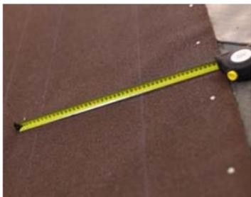
Зафиксировать с лицевой стороны эндовый ковер специальными кровельными гвоздями с отступом от края 20–30 мм с шагом 200–250 мм.
