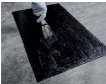
Нанести битумную мастику ТЕХНОНИКОЛЬ ФИКСЕР на всю тыльную поверхность выкройки ендовного ковра ТЕХНОНИКОЛЬ. Полоса ендовного ковра должна быть шириной не менее 500 мм.
